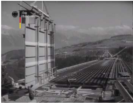
Abb. 3: Bauteil schwebt für den Bau der Europa-Brücke ein
